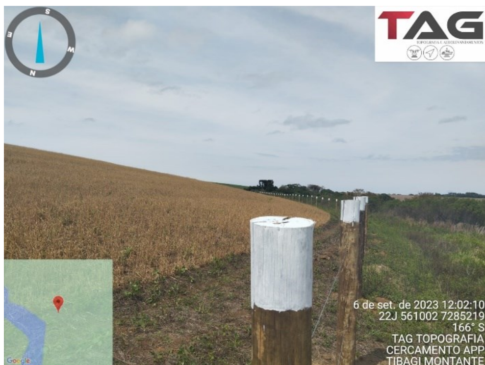
Figura 5-35: Trecho da APP da UHE Tibagi Montante isolado com cerca.
