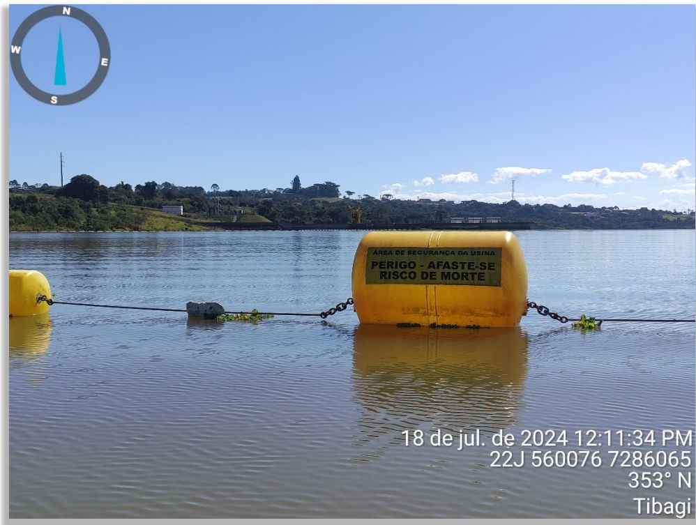
Figura 5-40: Sinalização de montante com placa informativa.
