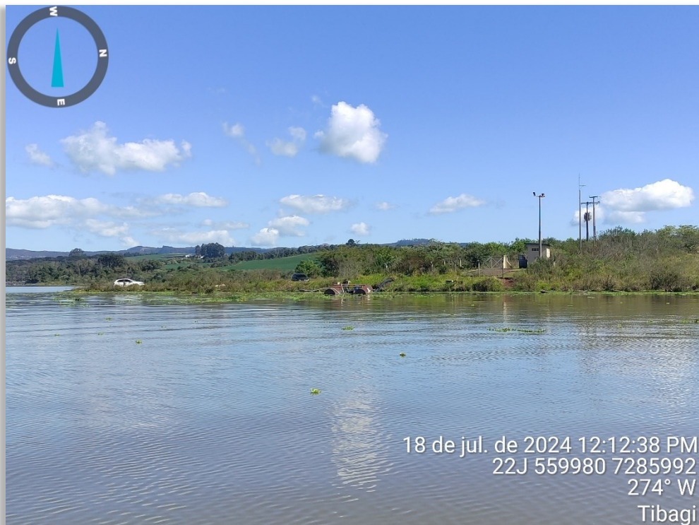
Figura 5-43: Captação de Água da SANEPAR no reservatório.
