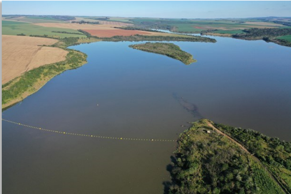
Figura 5-42: Captação de Água da SANEPAR no Reservatório. Foto julho de 2024.
