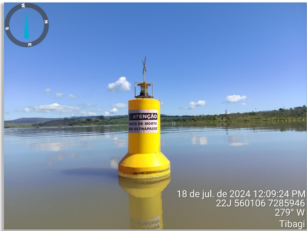
Figura 5-41: Boia refletora de segurança instalada no reservatório.
