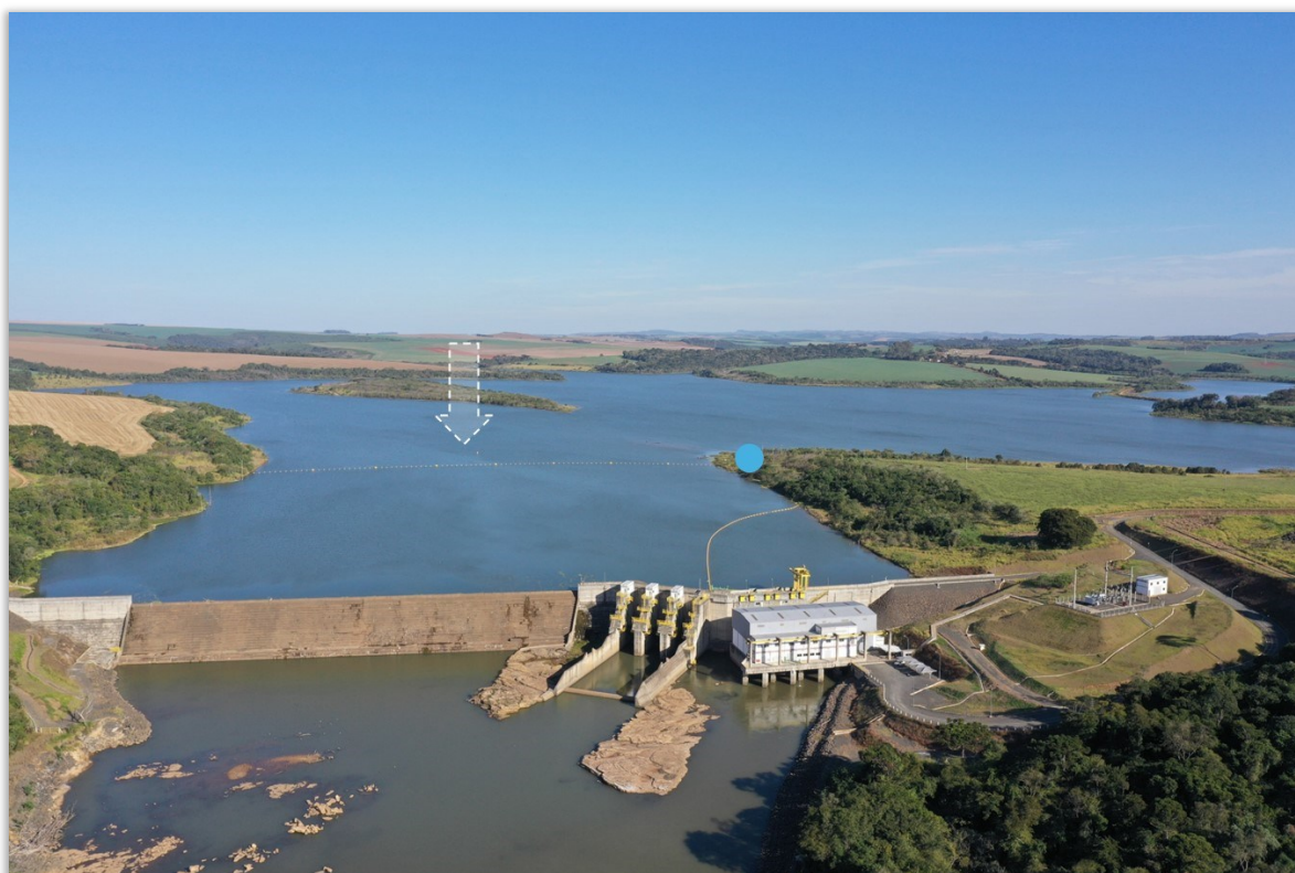
Figura 5-39: Boias de sinalização de montante (seta branca) a 500 metros do barramento. Ponto azul identificando o local de captação de água da SANEPAR. Foto junho de 2024.
