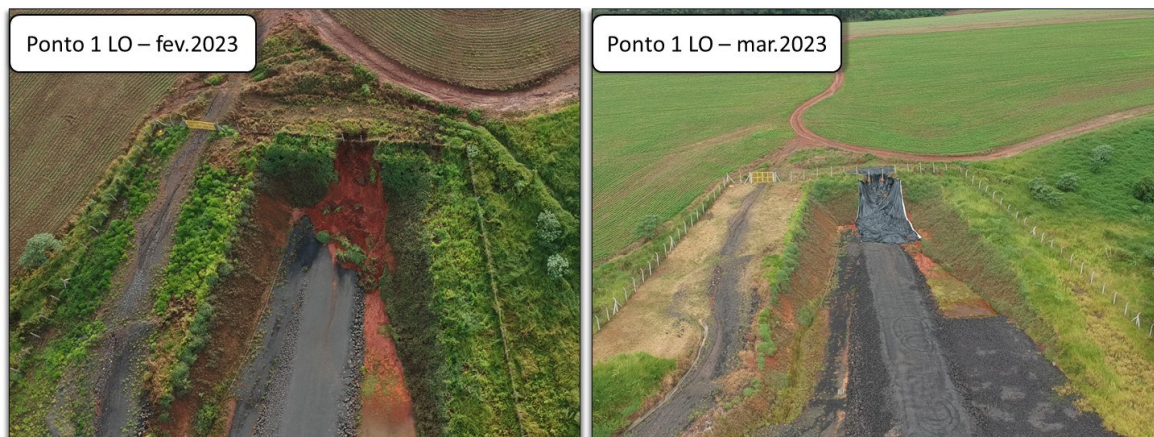
Figura 10: Tratamento da erosão sendo realizado, 1ª medida adotada foi o recobrimento do taludo com lona.
