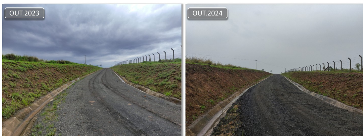
Figura 4-2: Estrada de acesso a UHE Tibagi Montante.
