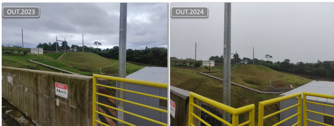
Figura 4-3: Vista para os taludes da subestação da UHE Tibagi Montante.
