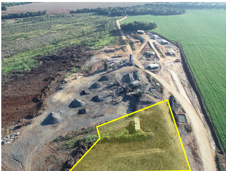
Figura 4-5: Canteiro industrial em junho de 2019. Área em amarelo demonstrando o local que foi devolvido ao proprietário.
