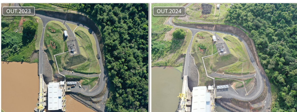
Figura 4-4: Vista aérea dos taludes da UHE Tibagi Montante.
