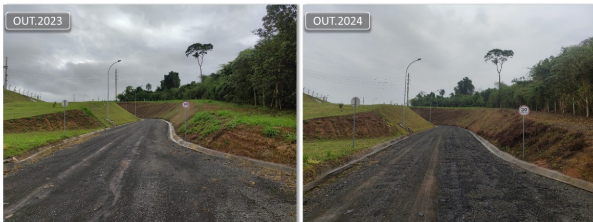
Figura 4-1: Estrada de acesso a UHE Tibagi Montante.
