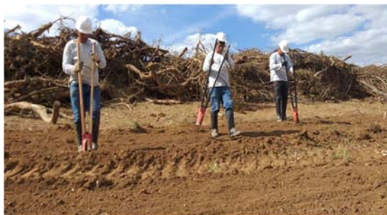
Figura 4-1 - Realização das cavas para alocação das mudas
